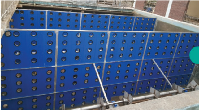
경남 김해시 삼계정수장 침전지 PHP정류벽 시공
