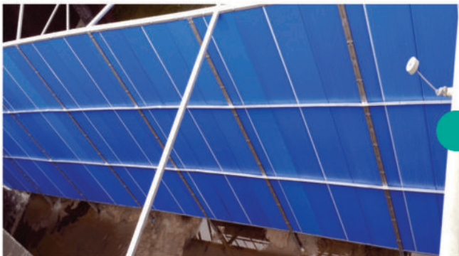
대덕하수처리장 조가름 PHP격벽 시공
