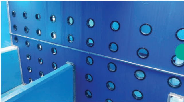
광주광역시 용연정수장 PHP정류벽 시공
