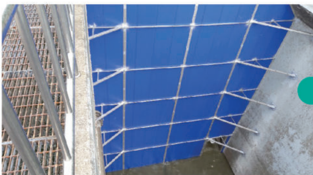
안양시 석수하수처리장 PHP간벽 시공
