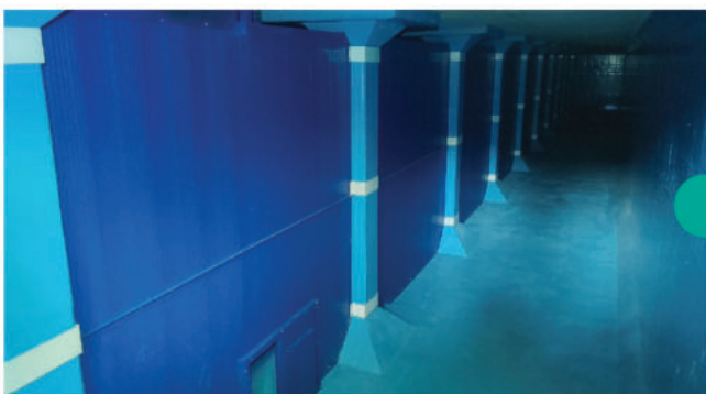
평택시 국제화배수지 PHP도류벽 무양카공법 설치
