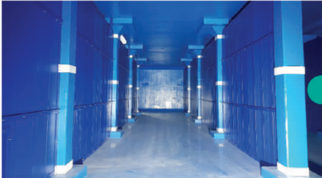
LH 김포 한강신도시 배수지 PHP도류벽 무양카공법 설치
