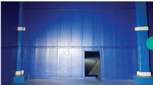
LH 인천검단배수지 PHP도류벽 무양카공법 설치
