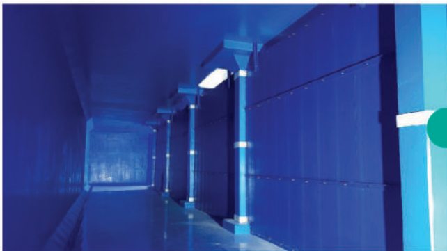
LH 화성 동탄 저,고 배수지 PHP도류벽 설치 무양카공법 설치
