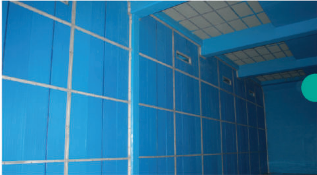
광주광역시 효천하수처리장 PHP간벽 시공
