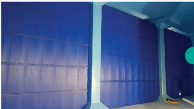
부산광역시 의.과학산업단지 배수지 PHP도류벽 설치
