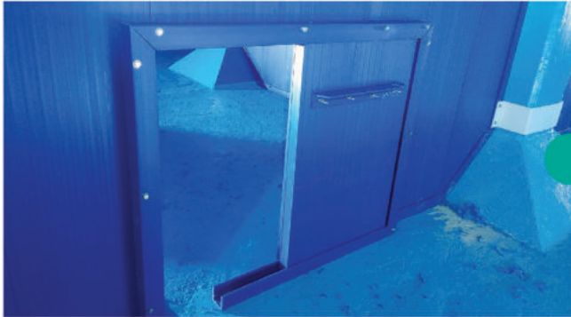
대전광역시 월평정수장 배수지 PHP도류벽 무양가공법 설치
