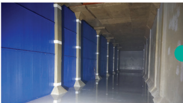
이천시 현대화사업 정수지 PHP도류벽 무양가공법 설치
