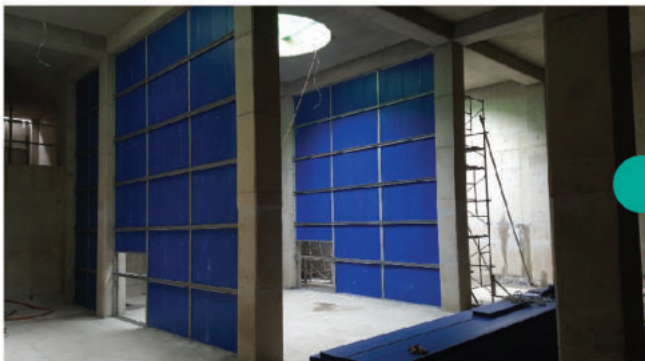
창원시 하수처리장 PHP간벽 시공
