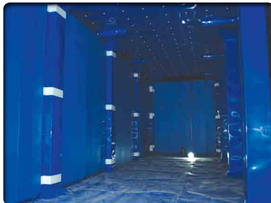
▲ 김포 한강신도시 PHP도류벽 무양카공법 설치 판넬을 기둥벽에 PE밴드로 단단하게 고정하여 누수방지 및 미관상 우수
