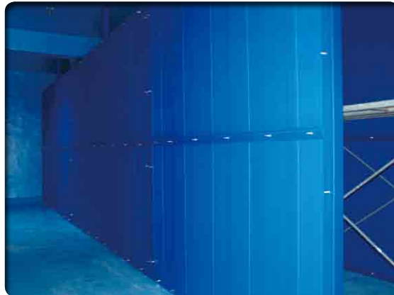
▲ 속초 설악정수장 배수지 PHP도류벽 설치 PANEL : HDPE, 65T / CHANNEL : HDPE 8T
