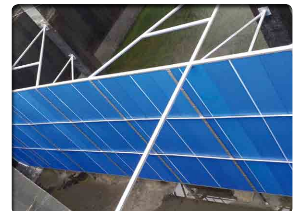
▲ 대덕하수처리장 PHP간벽 시공 PANEL : HDPE, 65 / CHANNEL : STS304
