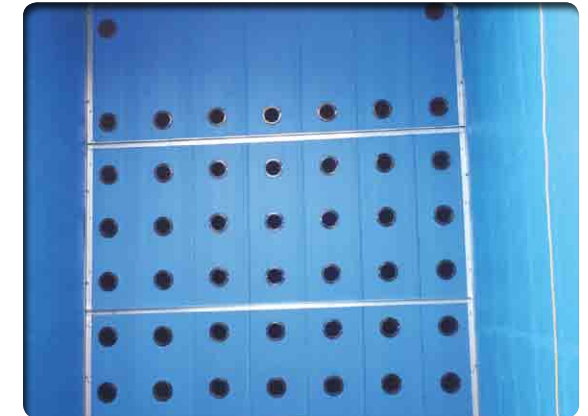
▲ 괴산 폐수처리장 PHP정류벽 시공 PANEL : HDPE, 65T / 정류공 : HDPE, 135A
