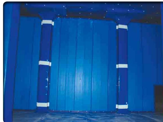
▲ 인천 서창 배수지 PHP도류벽 무양카공법 설치
