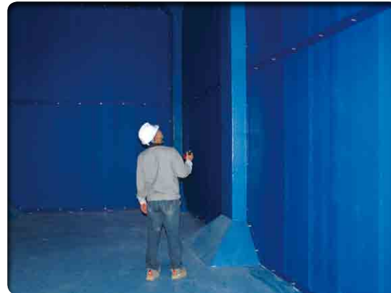
▲ 진천 산수배수지 PHP도류벽 설치 PANEL : HDPE, 65T / CHANNEL : HDPE 8T
